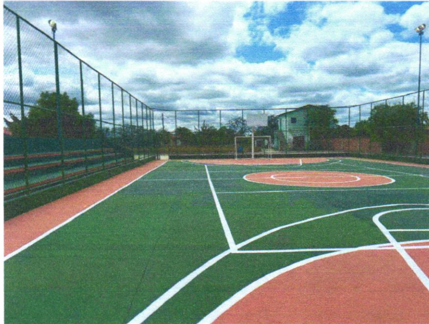
Foto 03 – Estrutura metálica fixa, p/ tabela em aço com aro e cesta p/ basquete, padrão oficial, em tubo galvanizado d=5" - instalada
