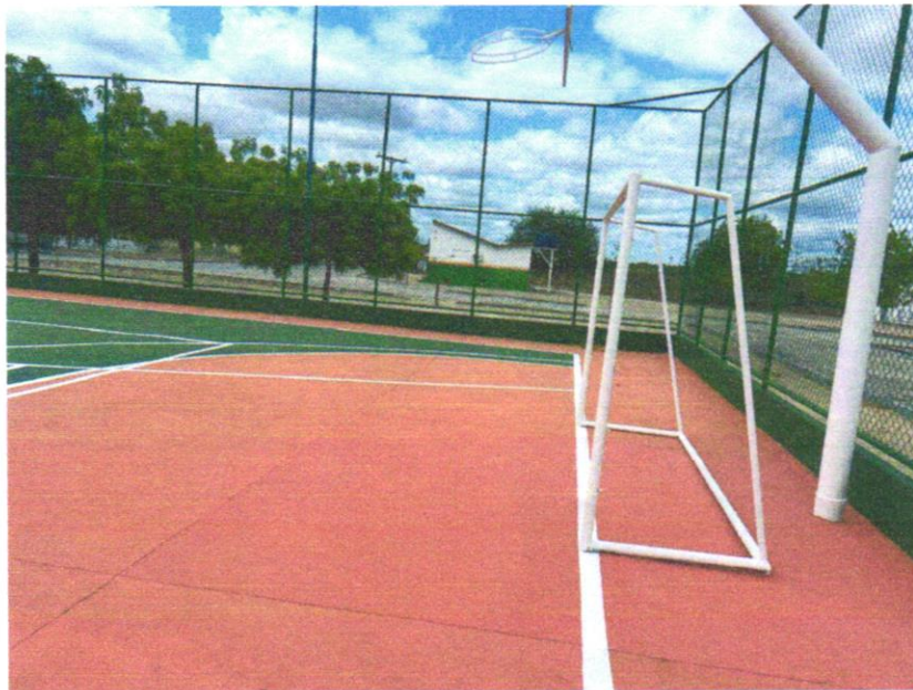
Foto 01 - Traves oficial para futebol de salão 3x2m em aço galv.3", com requadro e redes de polietileno fio 4mm (conjunto p/futsal)
