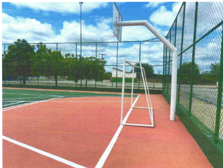
Foto 04- Estrutura metálica fixa, p/ tabela em aço com aro e cesta p/ basquete, padrão oficial, em tubo galvanizado d=5" - instalada
