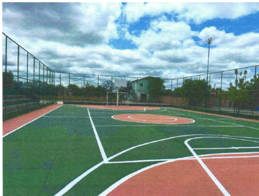
Foto 05 - PINTURA DE PISO COM TINTA ACRÍLICA, APLICAÇÃO MANUAL, 2 DEMÃOS, INCLUSO FUNDO PREPARADOR. AF_05/2021
